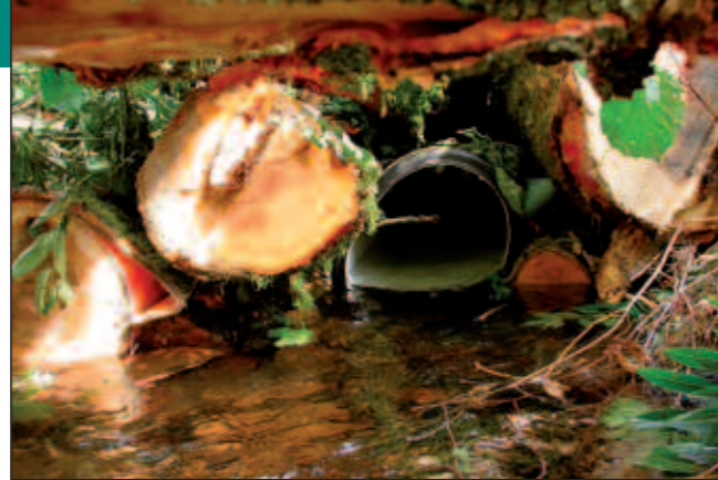
Sous les rondins, le tube se déforme, mais ne casse pas
