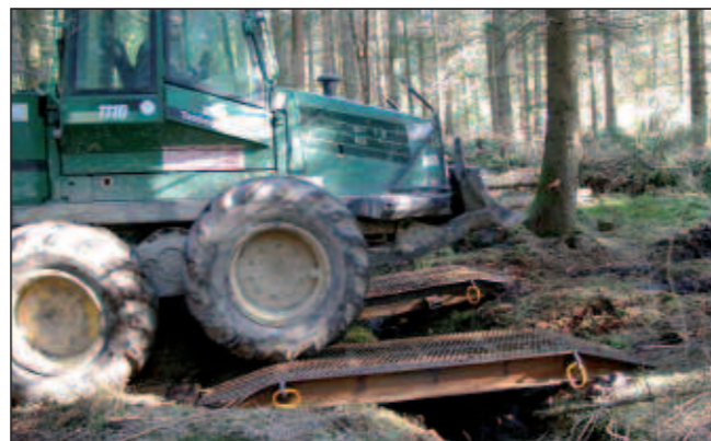
Tracteur sur un pont métallique
