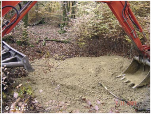
Figure 7 – Mise en place d'un bouchon étanche. À gauche : fixation du géotextile sur le bardage en bois. À droite : recouvrement à l'aide de matériau prélevé à proximité.
