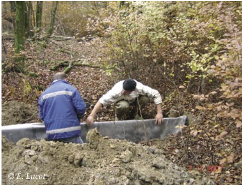
Figure 7 – Mise en place d'un bouchon étanche. À gauche : fixation du géotextile sur le bardage en bois. À droite : recouvrement à l'aide de matériau prélevé à proximité.
